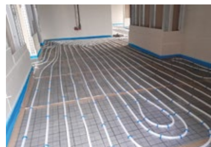
... und ein Blick ins Innere bei der Verlegung der Fußbodenheizung.
